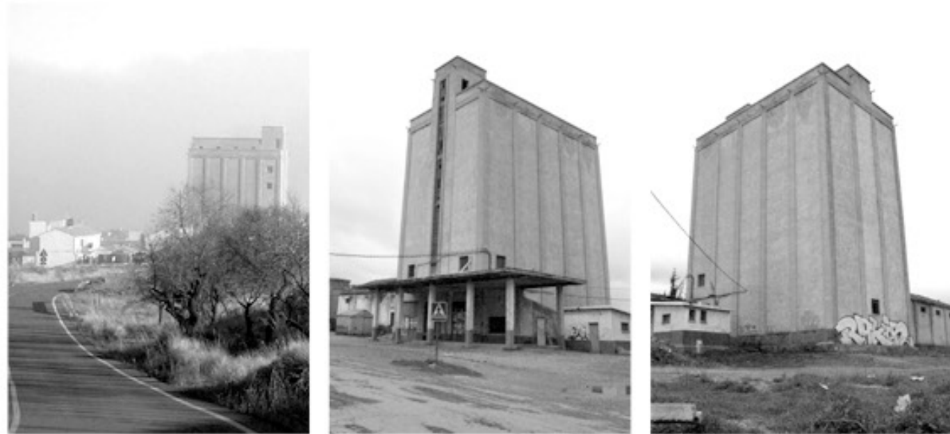
silos en la calahorra, provincia de granada, españa
