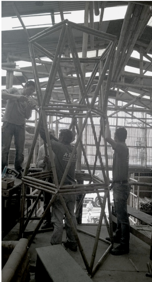
Últimos retoques a la estructura de guadua.
