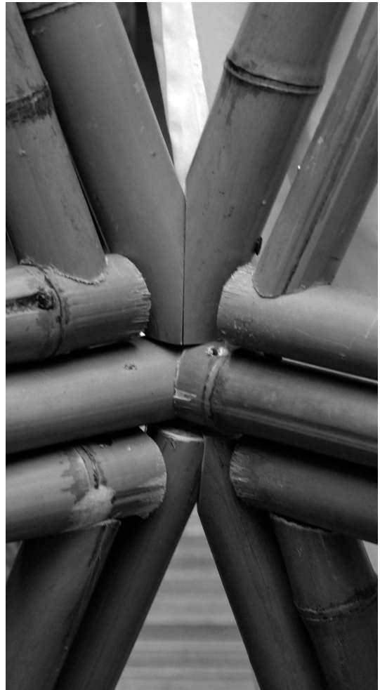
Detalle de unión de guaduas.
