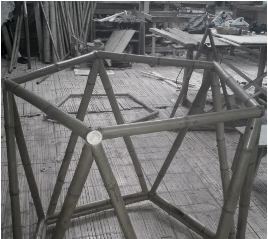
Base de la estructura de Guadua.
