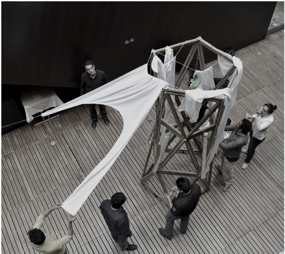
Tensionado de la cubierta textil.
