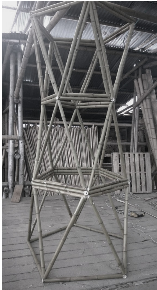
Estructura de Guadua en pie.
