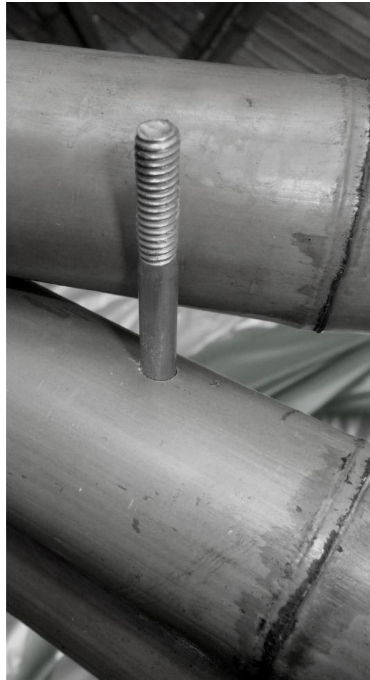
Detalle de unión de guaduas.
