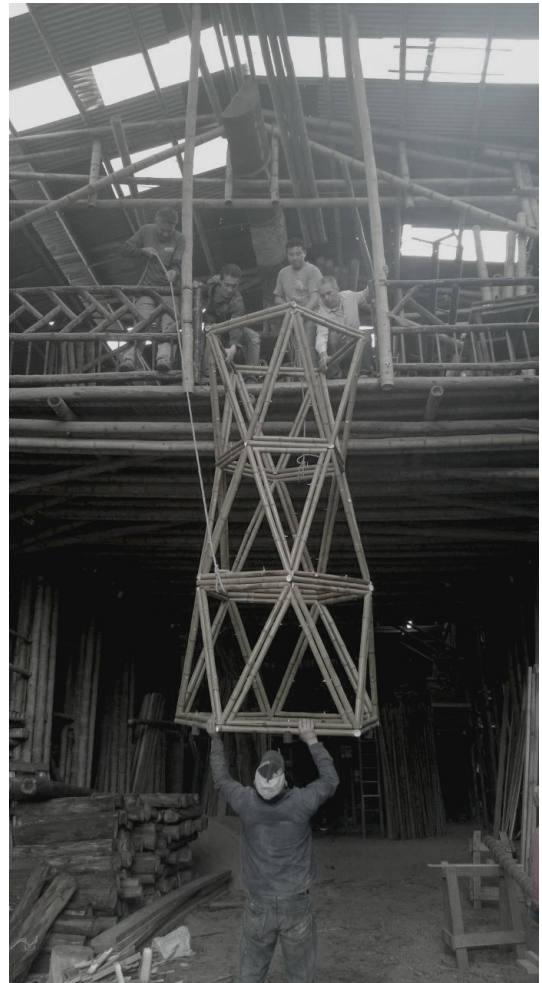
La estructura de guadua lista para transportar.
