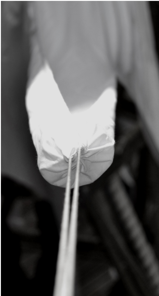
Detalle de tensores.
