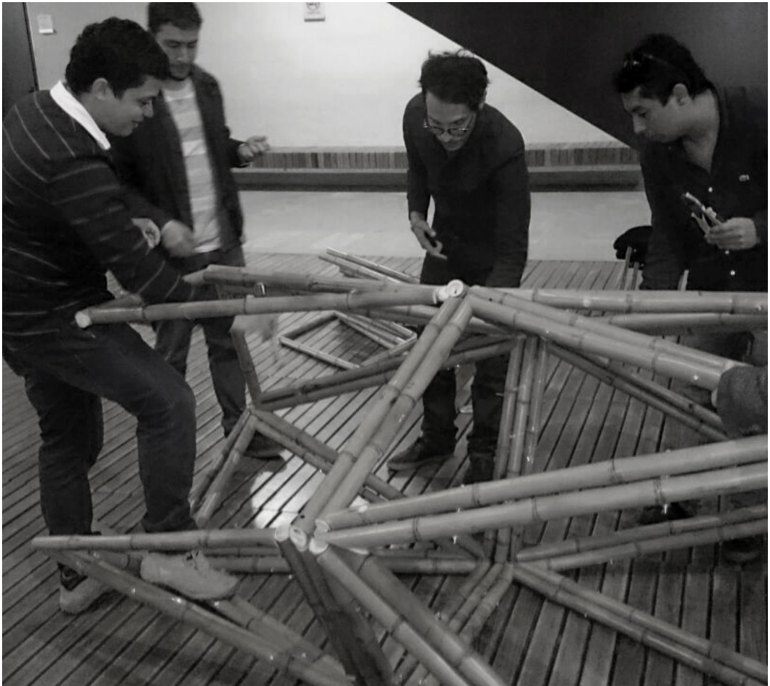
Desmontaje de la estructura de guadua.
